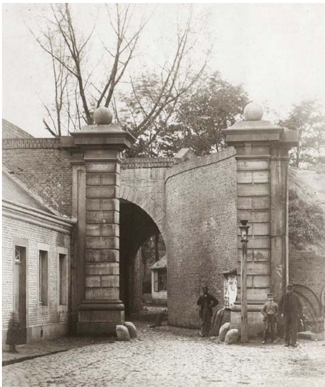
Boven: De Sint Pieterspoort van de stadzijde. Het kronkelige verloop is opzettelijk en een gevolg van 'moderne' vestingbouw. Daardoor waren dit soort poorten ook een bottleneck in de uitvalswegen.
