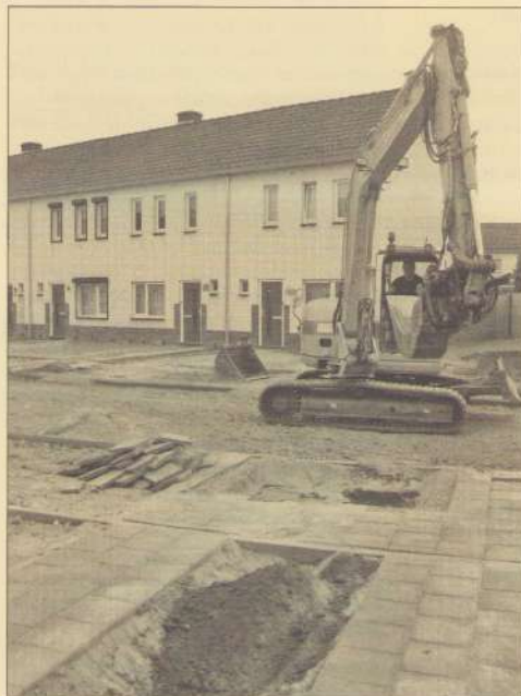
De renovatie duurt lang hier, het is strompelen en struikelen voor de bewoners.
