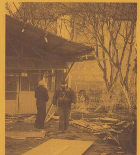
V.m. Groene Kruisgebouw tijdens afbraak. Hier zullen drie woningen verrijzen.
