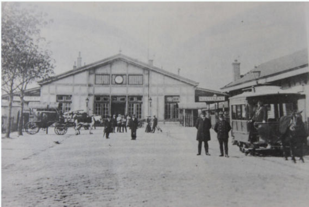
Het oude houten stationsgebouw uit 1853.
