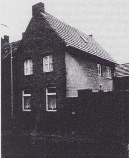
Pand Dorpstraat 71. Op de foto op pagina 18/19 staat dat huis afgebeeld als een wit huis. Het gaat echter over hetzelfde pand. In 1949 werd het verhoogd en voorzien van een gemetselde voorgevel.
