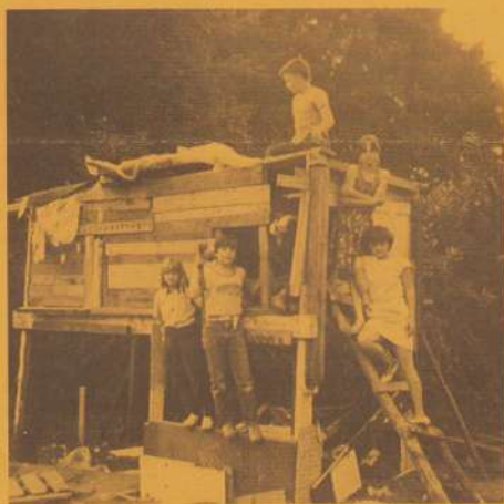
De voormalige bouwspiegelplaats
