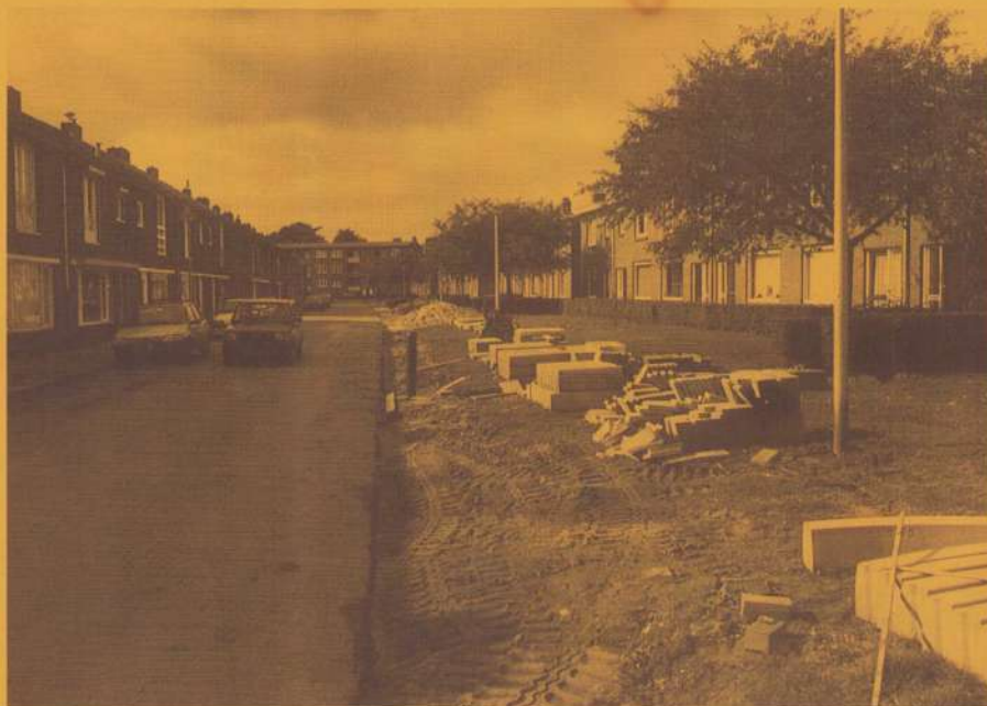
De opknapbeurt van de bestrating in Tuinwijk is bijna voltooid. Hier ziet U de aanleg van de parkeerhaven in de Merovingenstraat. (foto Paul Rutten - gemeente Maastricht)
