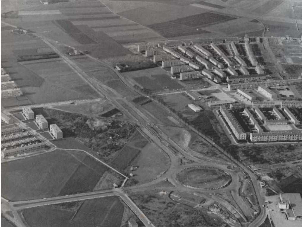
De aanleg van de Via Regia: aansluitend op de nieuwbouwwijk Caberg (rechts) zal Malberg verrijzen.
