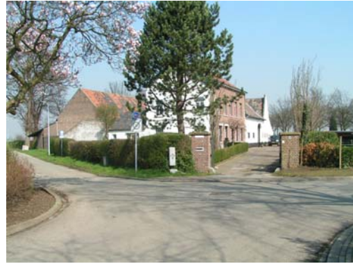
De oprit van Postbaan 8 maakt deel uit van het vroegere verloop van de weg.
