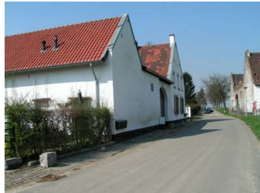
Het noordelijk deel van de Van Akenweg heeft geen stoep.
