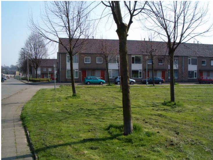
Eengezinswoningen aan het Vendelplein die hiërarchisch een tree hoger op de ladder staan dan de woningen voor de “achterblijvers”. Opvallend is het gérende verloop van de straat.
