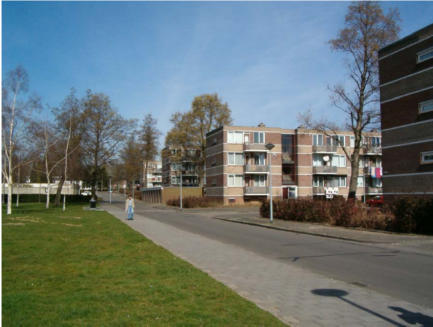
De Busselruwe met de green van het Busselplein. Het verloop van de straat volgt het reliëf van het oude landschap. Rechts bevinden zich de flats van Jos Muré met hun opvallende baksteenpolychromie, met daartussen de omhaagde 'groene kamers'. Links in de verte ziet men de lage daklijn van de patiowoningen van Gerard Snelder in dit kwadrant.
