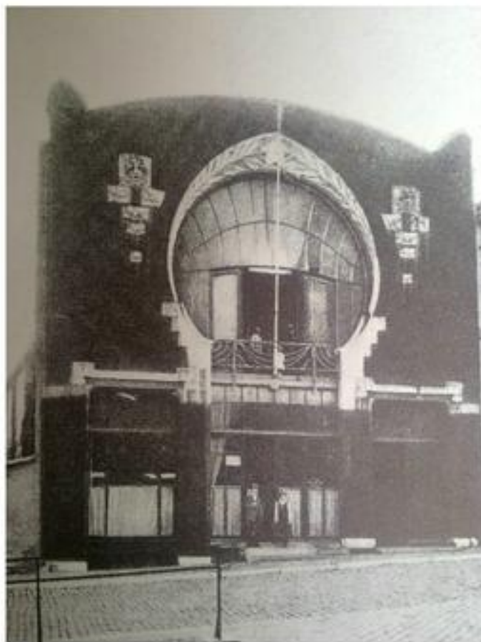
Stargebouw geopend in 1907 en afgebroken omstreeks 1953
