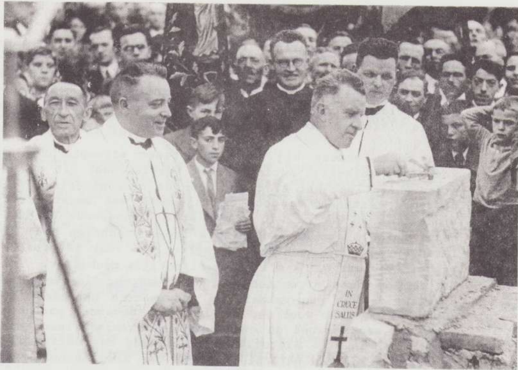
De eerste steenlegging door de deken van Wyck Frans Schoenmaeckers. Achter pastoor Janssen kijkt pastoor Jos. Heijnen van Heer toe.
